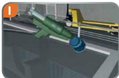
Universalgroßdose mit Heißkleber auf den Schaltisch kleben.
