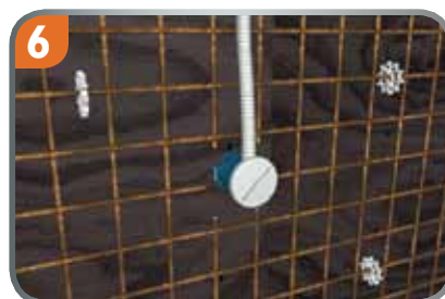
Rohre einführen und als z. B. Elektronikdose oder große Klemmdose verwenden.
