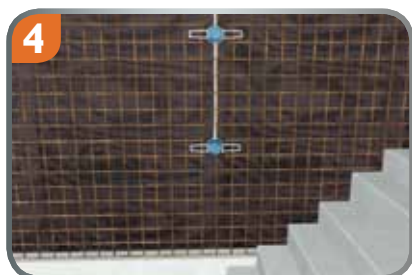
Universalgroßdose einfache Montage mithilfe der Flügel.
