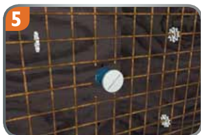
Universalgroßdose kann auch in der Wand mit Nägeln befestigt werden.
