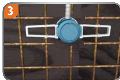
Montage mit Flügel auf der Stahlarmerung / Elektronikdose.
